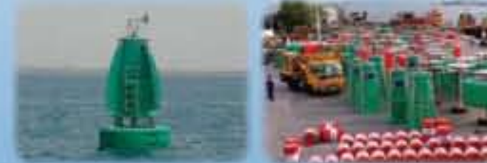
تركيب وتنصيب عوامات الإنارة الحديثة على طول القناة الملاحية لميناء عدن Installation of modern light buoys along the navigation channel of the port of Aden
