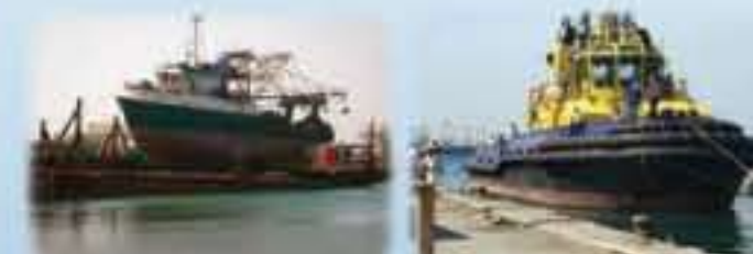
عمليات الصيانة والترميم للقاطرات البحرية والسفن السمكية على المزلق الرئيسي للمؤسسة Maintenance and repair of marine tugs and fishing vessels in the port using the main slipway of the corporation
